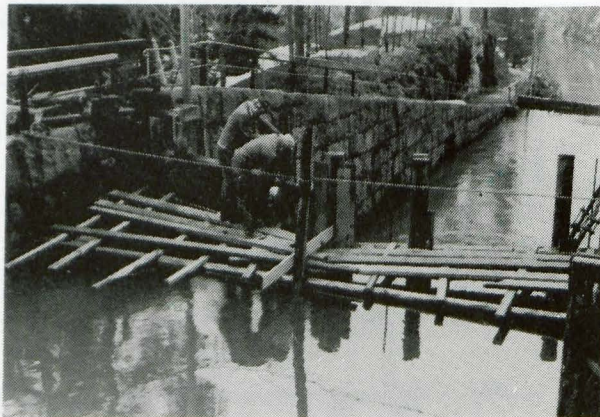
Riving av porten blei gjort frå oppsatt stilling.
