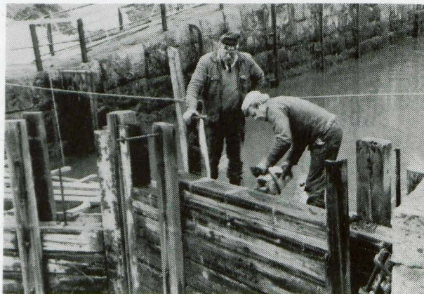
Portstokkane blir kabba i passe tunge kubbar med motorsag.
