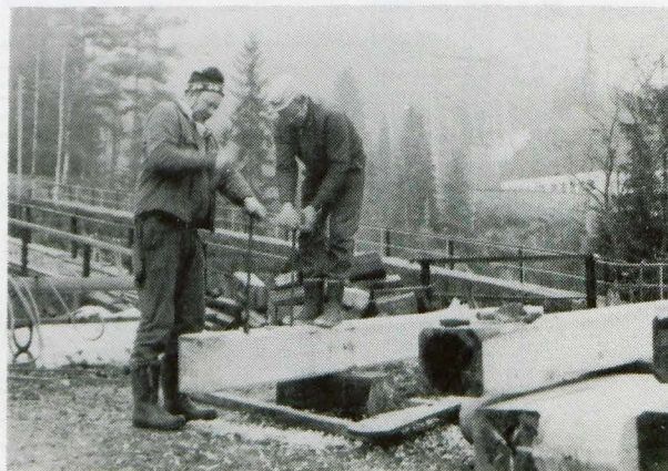
Stokkane må høvlast, boras og tilpassas etter mal, på land.
