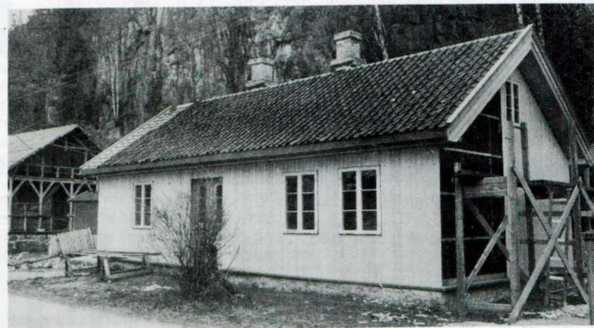
Bilde tatt under restaureringen
