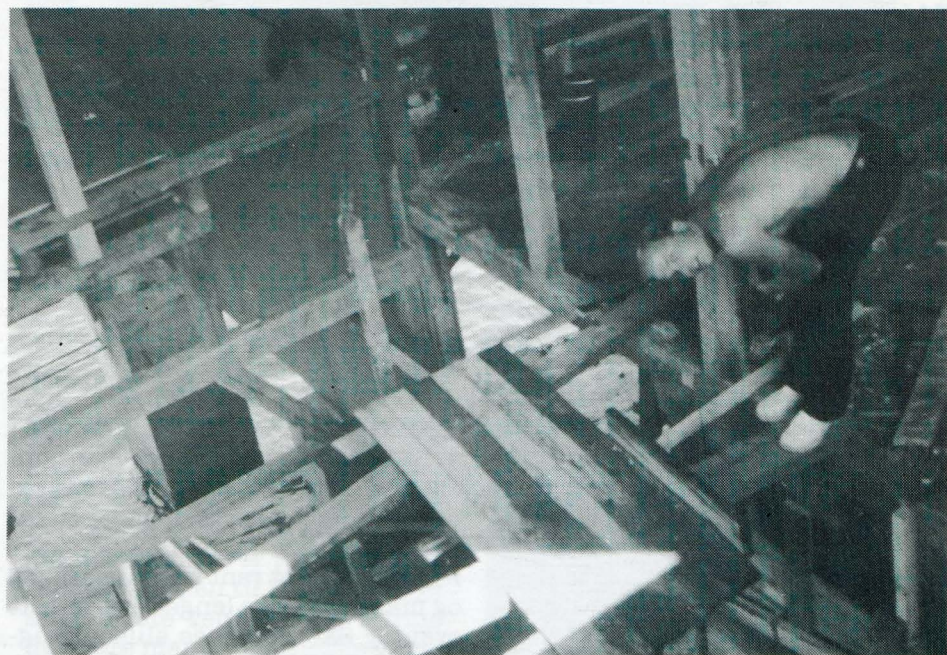
Nytt gulv over dypt vann . . . Bolighusdelen av pakkhuset trer fram.
