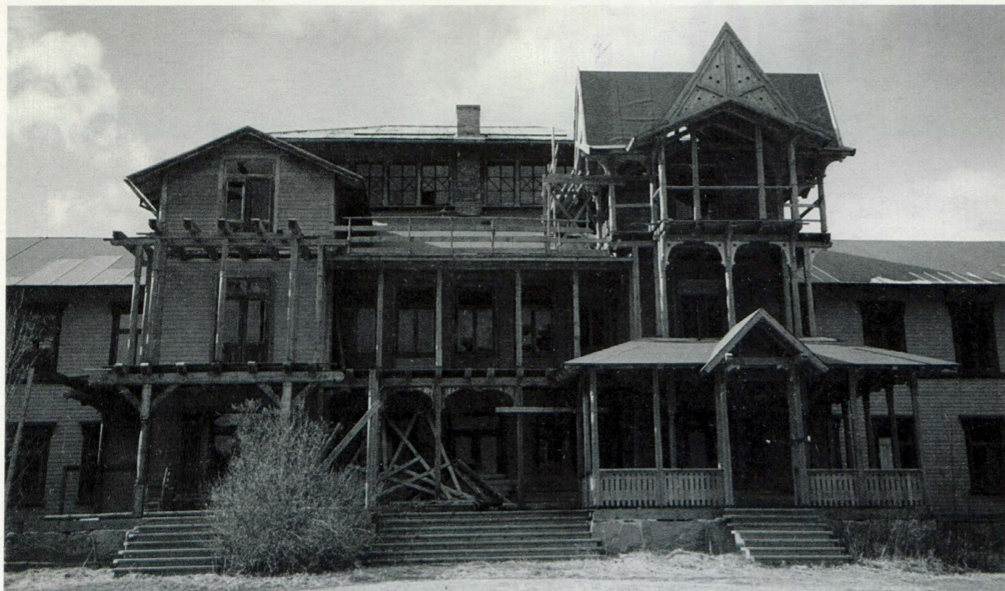
Fasade mot Bandak etter Åge Samuelsen's Rehabiliteringsarbeider. (1990).
