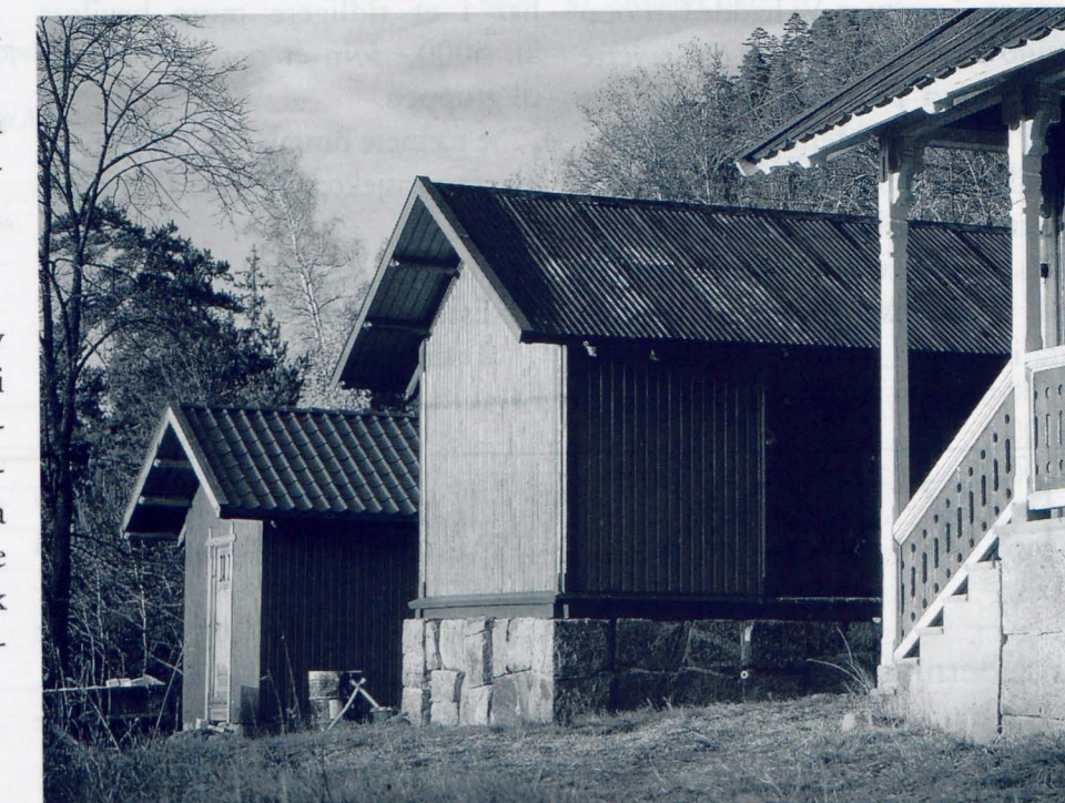
Bakstehuset på Eidsfoss er ferdig gjenreist.
