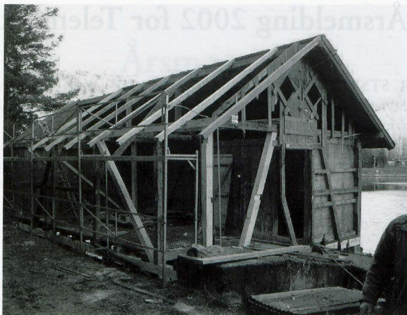
På søndre gavelvegg måtte all gammel kledning rivast. Ny botsvill er lagt og nokre nye stolpar i reisverket.
