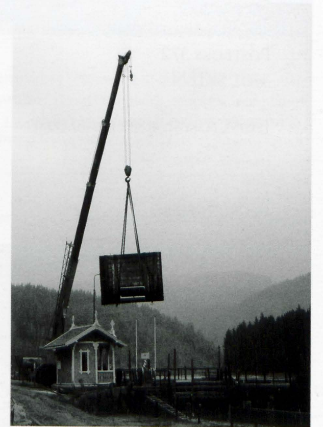
Portløft: Utskiftning av midtre port Hogga tidlig vår 2005. Portbladene deles og heises ut i 2 løft for ikke å bli for tunge for krana. Før i tida var det taljer og jekking som måtte til. Disse portbladene er med unntak av de øverste stukkene de originale fra 1892.
