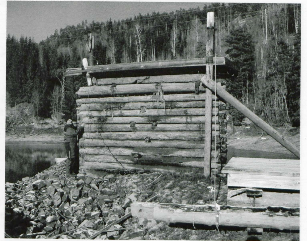
Lensekar ved Eidsfoss under nedtapping. Benyttes til å fortøye lenser og lensebrygger. Konstruksjonen står nesten helt under vann og er inntakt etter over 100 år! Slike har vi mange av!
