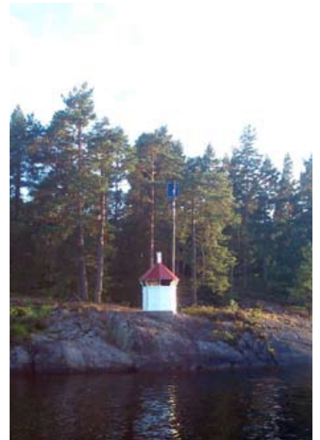
Stolpe med solcellepanel er plassert ved siden av lykta for å komme over trær og forhindre tyveri.
