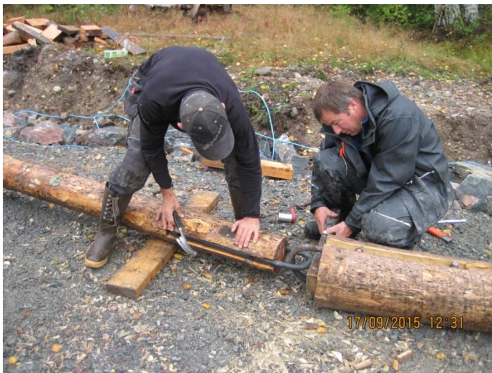
Montering av lenseklave.
