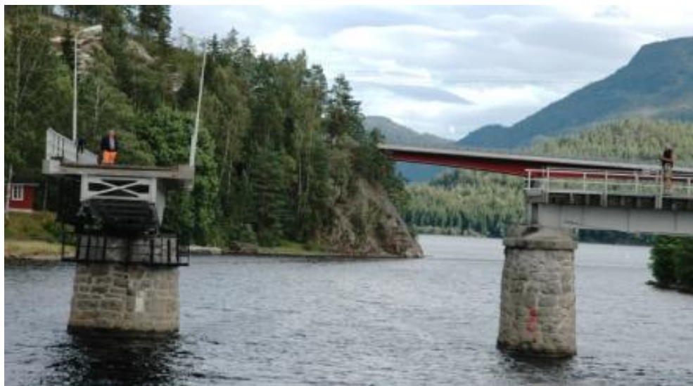
Sundkilen bru med Kviteseid bru i bakgrunnen. Under tv Sundkilen bru.
