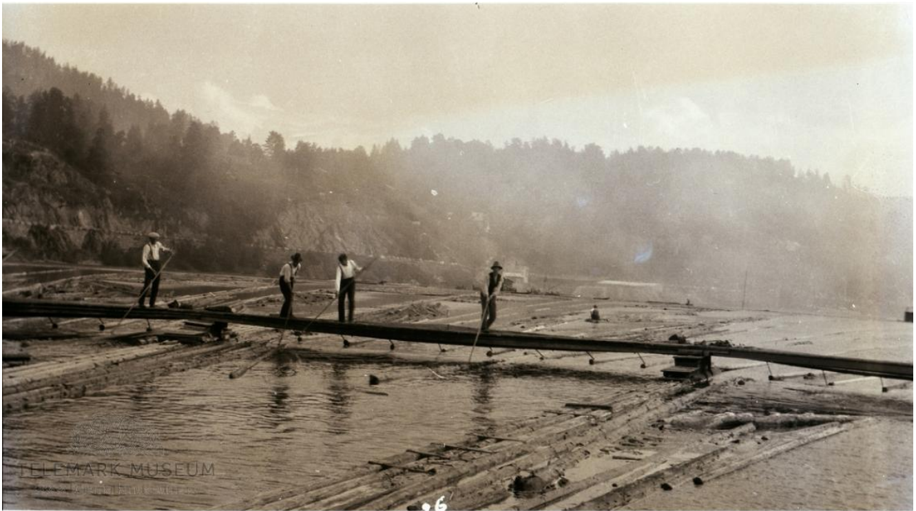
Frå Tinnålena. Tømmeret blei skilt i lommer etter merket til kjøparen. Foto Telemark museums bildesamling/Skiensvassdragets fellesfløtnings arkivTGM-SFF.00521
