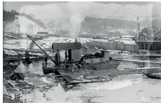
Graving og mudring: Rjukanbrygga ble anlagt i Tinnosandbukta rett øst for Hydros første salpeterfabrikk. Bukta ble stegvis fylt ut, slik at større arealer kunne nyttiggjøres. Foto: Norsk Hydro/NIA 5886.
