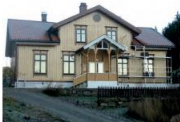
Vestfasaden på slusemesterboligen på Løveid før og etter tilbakeføring høsten 2020. Bygningens langfasader har fått tilbake vinduer, vindusomramminger og dekorative detaljer fra tidsrommet 1861-1900 og blitt malt opp i farger fra andre halvdel av 1800-tallet. Fotos: Tor Kjetil Gardåsen
